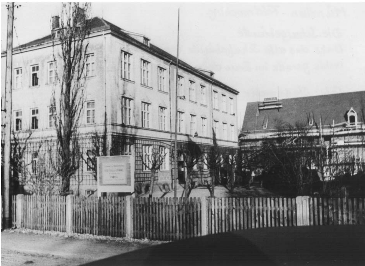
Altbau (Vordergrund) und Neubau im Winter 1937
